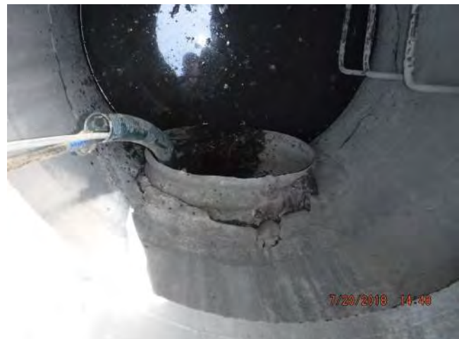
Effluent pipe connection
