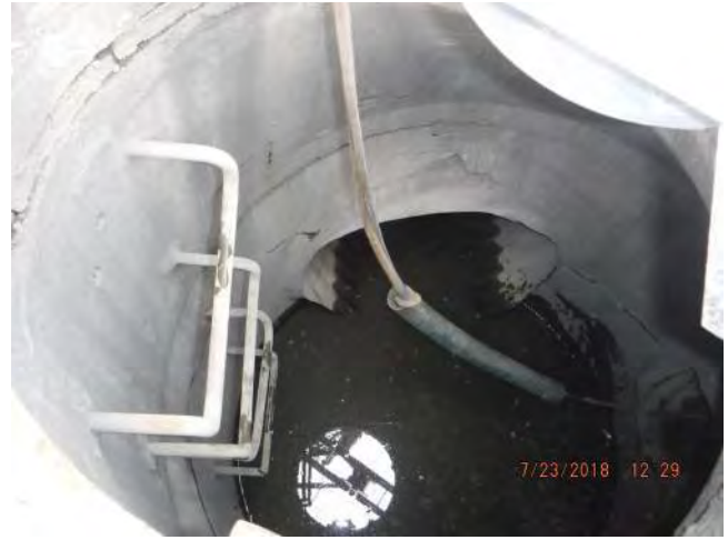
Mainline effluent connection
