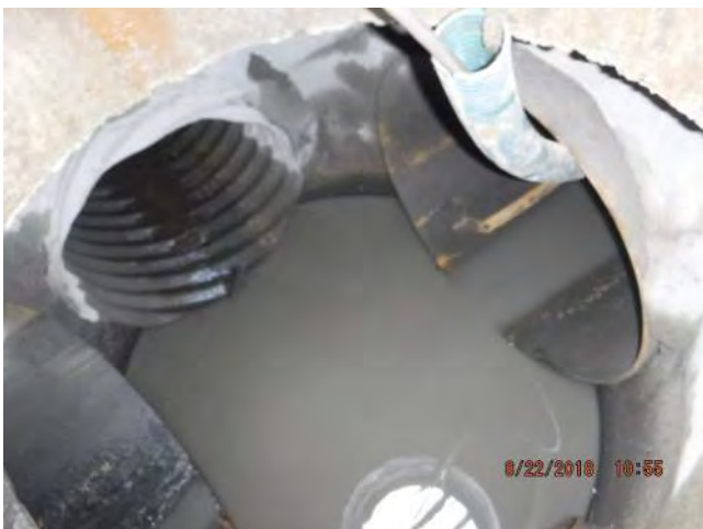
Effluent mainline connection
