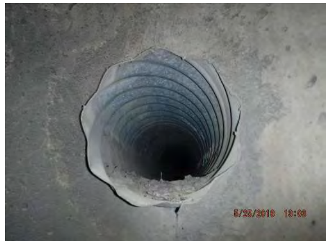
12" Fin Drain Connection
