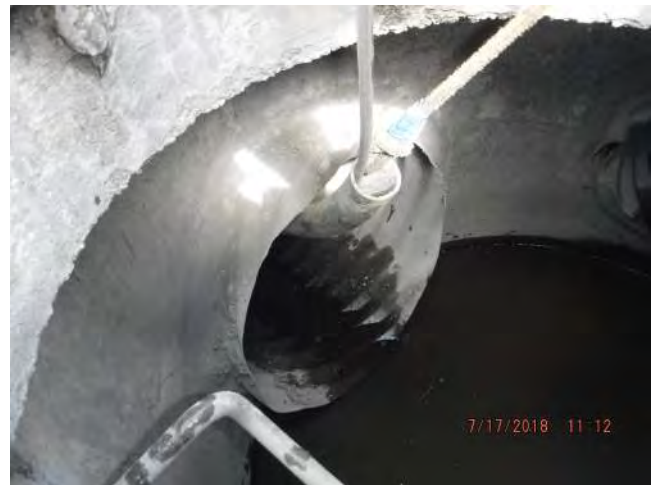
Effluent mainline connection
