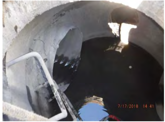
Effluent Mainline Connection
