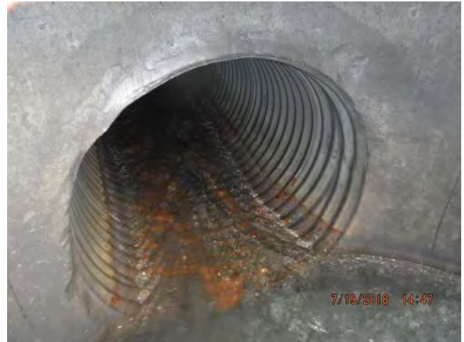
Effluent mainline connection
