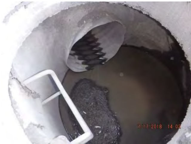
Effluent mainline connection
