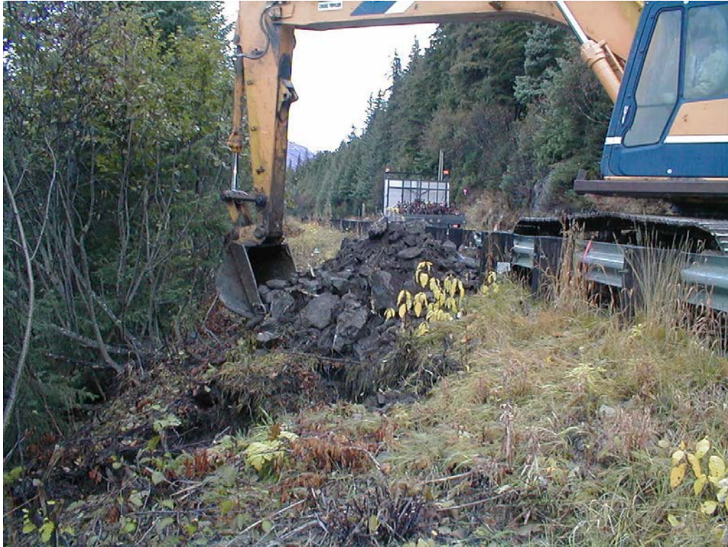
Test Pit TP 00-52
